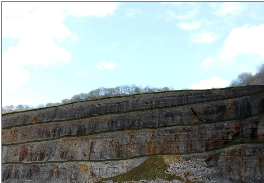
Vue des fronts de taille et cône d'éboulis en végétalisation libre au sein de la carrière
